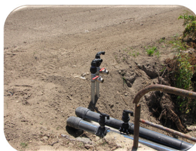
Instalação da rega gota a gota enterrada (14/4/2015)
